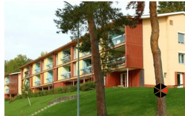
Umbauten und Anbauten Winzerhalde, Zürich. Knapkiewicz & Fickert
