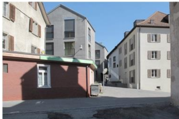
Nachverdichtung im Dorfkern Haldenstein. Architekturbüro Miroslav Šik
