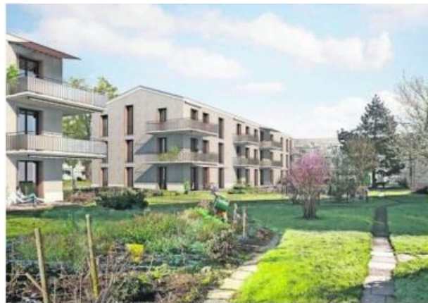
Ersatzneubau Talgut, Winterthur. Architekturbüro Miroslav Šik
